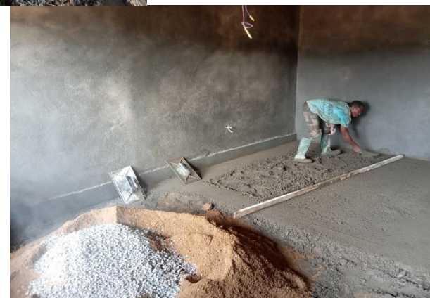
Coulage et lissage du sol en cours ...
