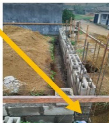
...et les fondations
