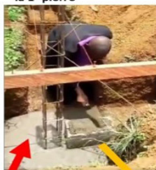
Puis la pose de la 1 re pierre
